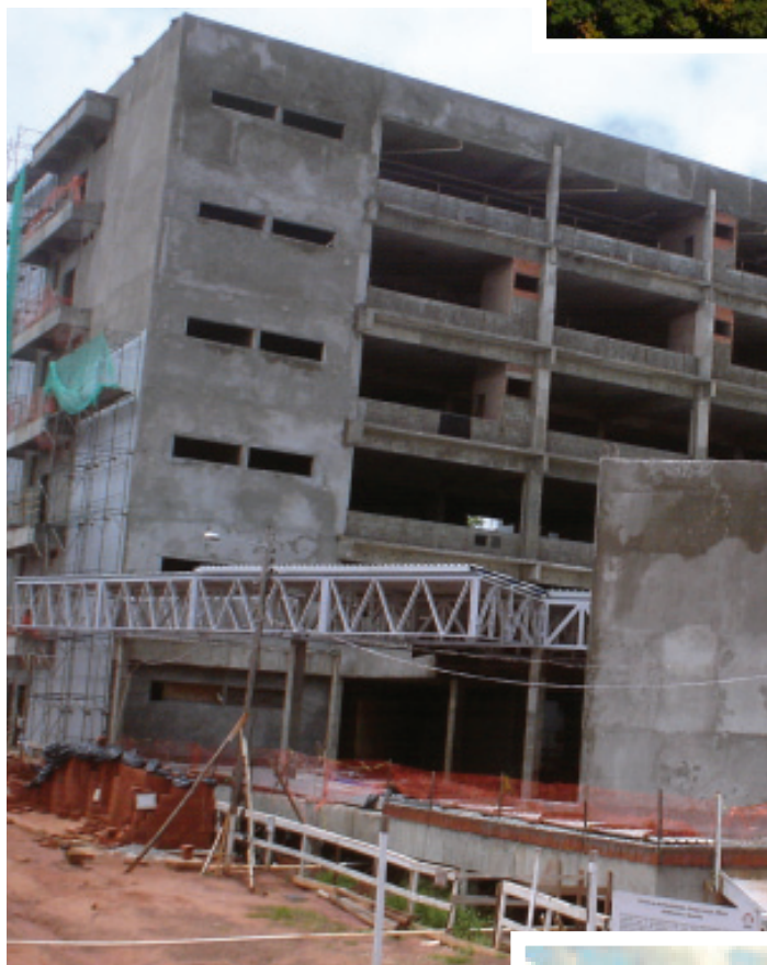
Obras do edifício-sede do TRT da 24ª Região em Campo Grande.
