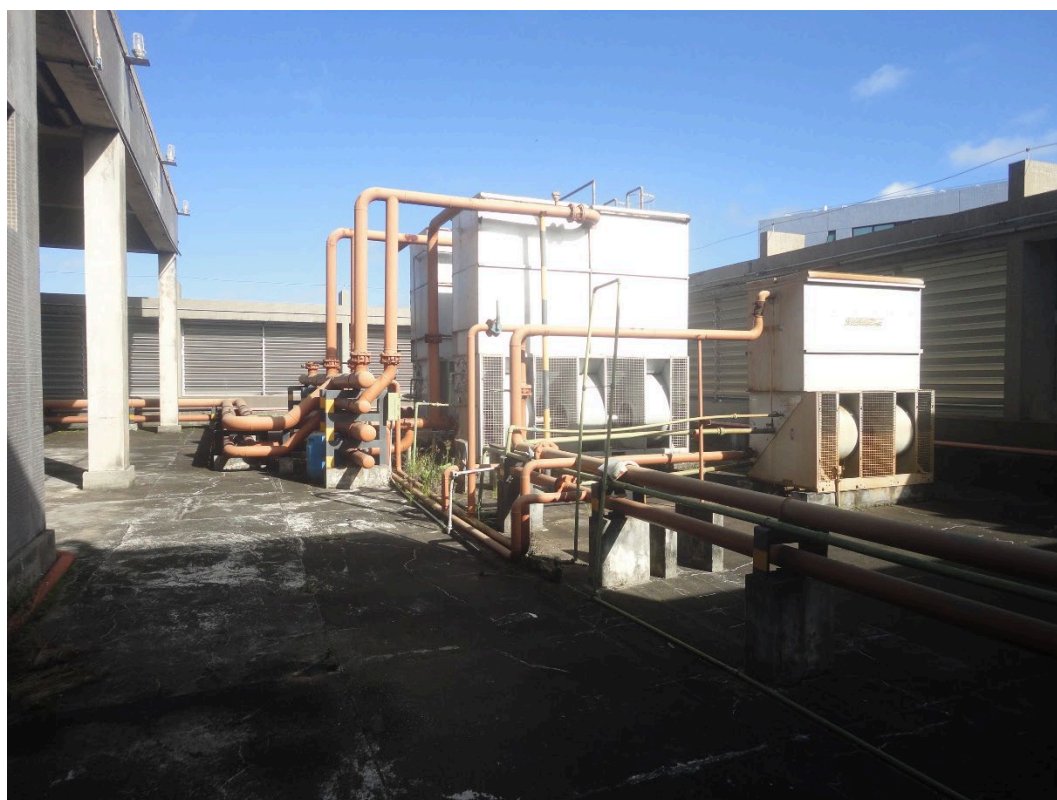
FOTO 186 – COBERTURA – TORRE DE REFRIGERAÇÃO
