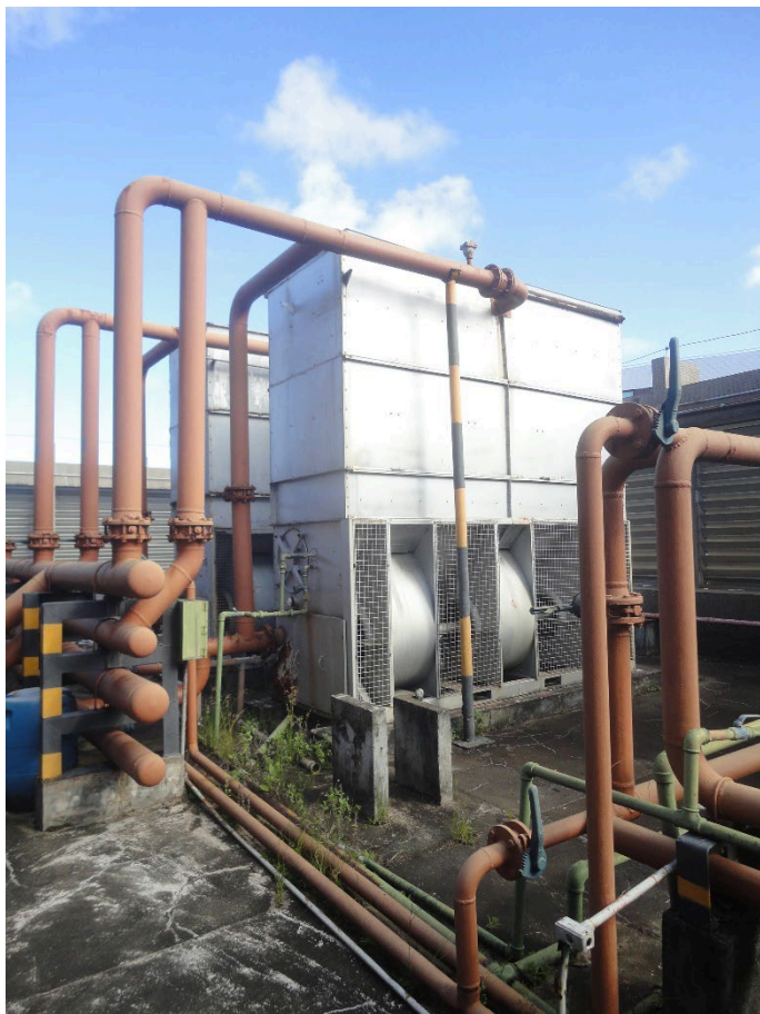
FOTO 183 – COBERTURA – TORRE DE REFRIGERAÇÃO
