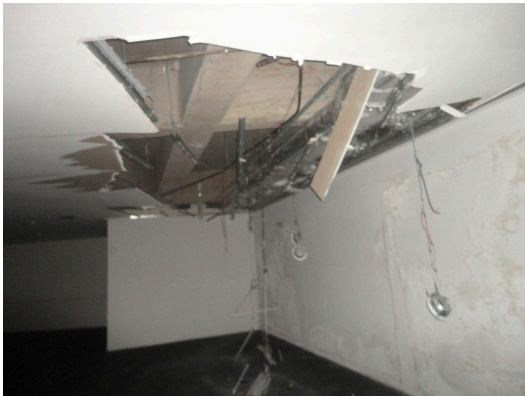
FOTO 71 – PRIMEIRO PAVIMENTO – SALÃO COM VAZAMENTO NA FACHADA
